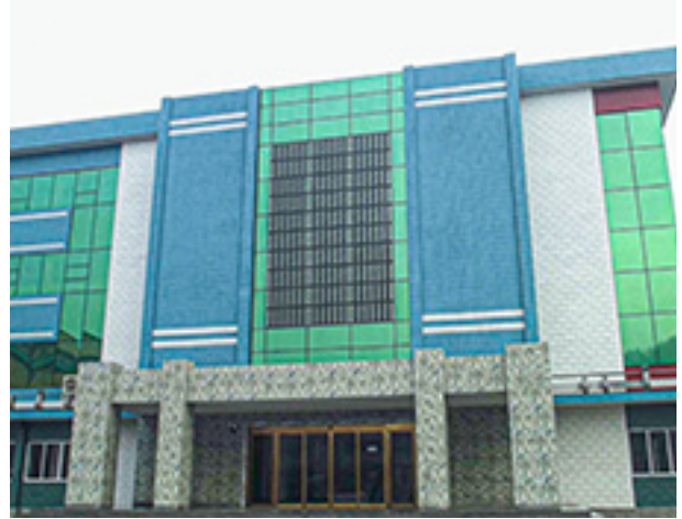
그림 카렌월유리벽구조와 결합된 반투과형태양전지채광창(외부)
