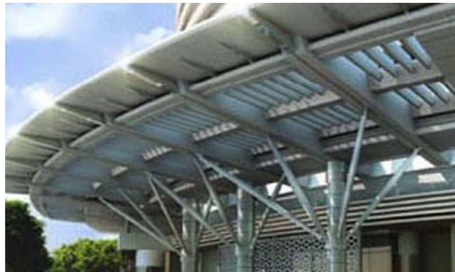
그림 립체트라스구조를 적용한 현관부와 채양구성실례
