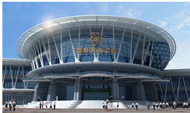
그림 립체트라스구조를 적용한 현관부와 채양구성실례
